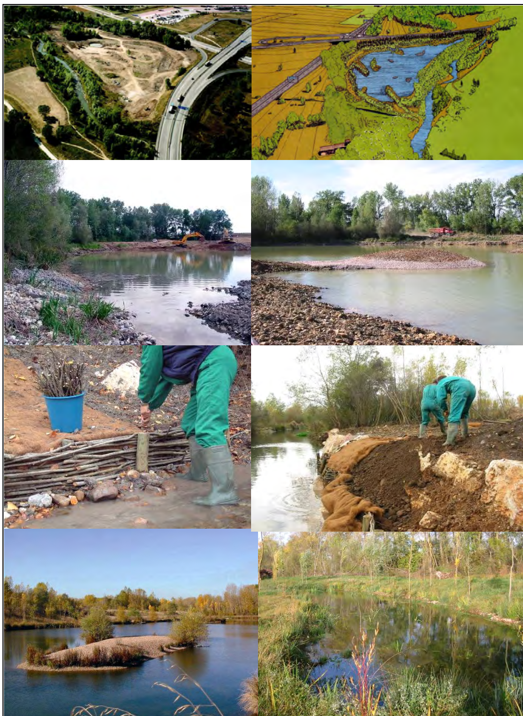
Figura 131. Diferentes fases en la creación de un humedal artificial en un meandro abandonado del río Arlanzón, Burgos. Fuente: Hydra S.L.
