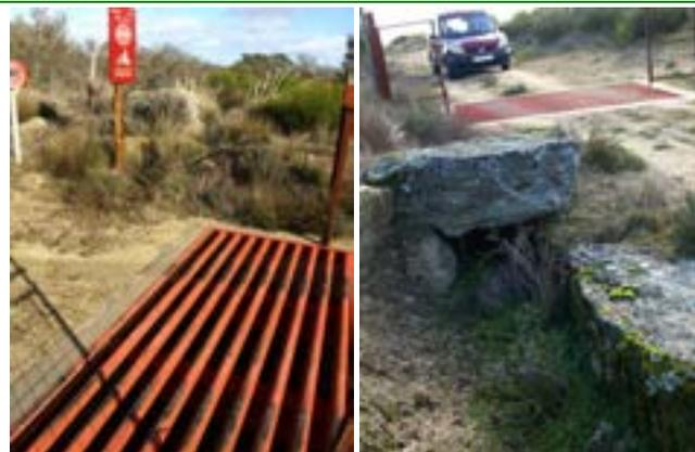
Emparrillado de tubos de hierro con un gran hueco y una salida de fábrica para el agua y la fauna instalado en el GR-14.
