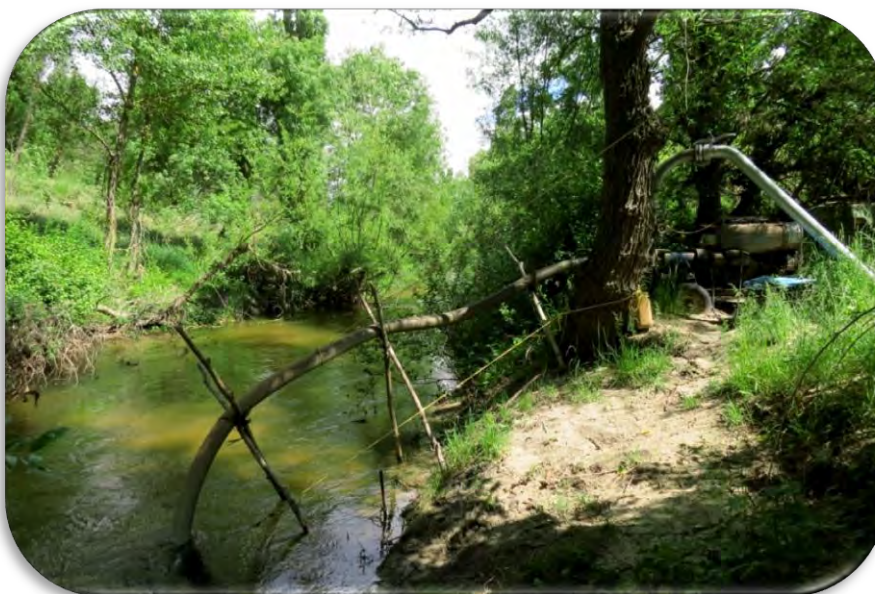
Captación de agua mediante entubado en el río Cega. LIC "Riberas del río Cega y afluentes".
