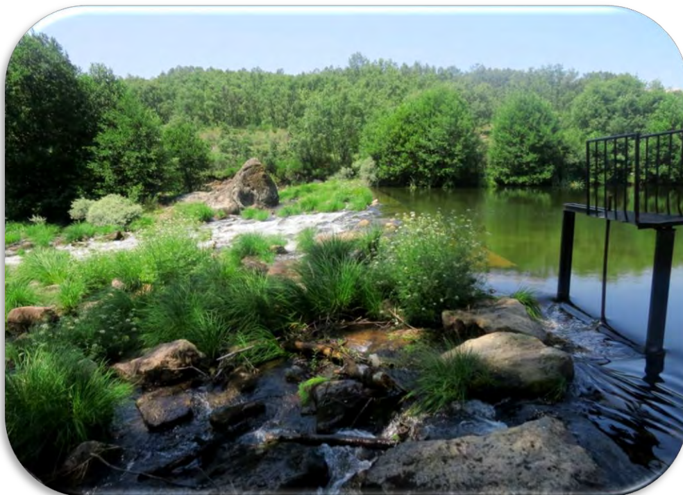
Azud en el río Tera con renovación permanente del agua y presencia de O.curtisii . LIC "Riberas del río Tera y afluentes".
