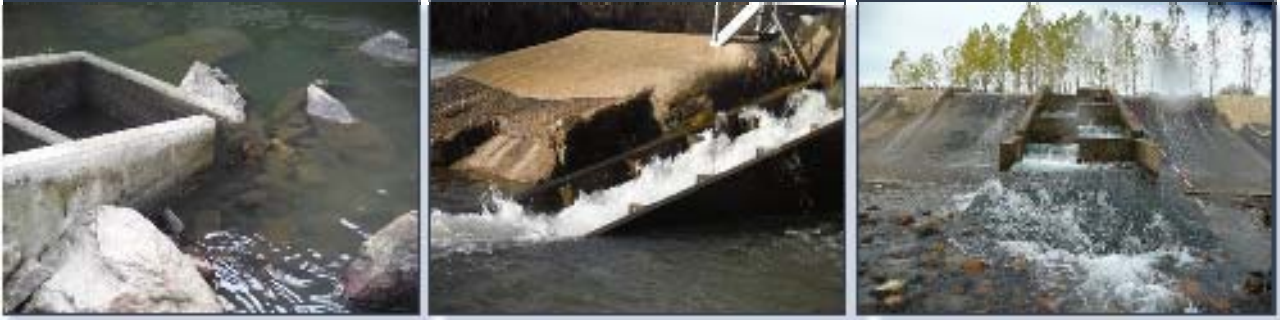
Figura 15. Entradas con diferentes anchuras: 20 cm (izquierda), 80 cm (centro) y más de 100 cm (derecha).
