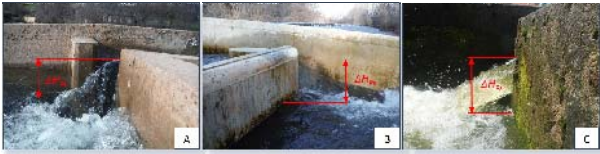
Figura 24. Croquis del desnivel entre láminas de agua de estanques sucesivos en escalas con hendiduras verticales (A), vertederos sumergidos (B) y vertederos libres (C).
