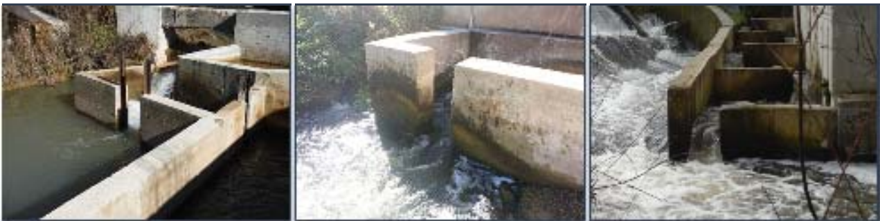
Figura 9. Desnivel entre las láminas de agua en la entrada reducido (izquierda), adecuado (centro) y excesivamente grande (derecha).
