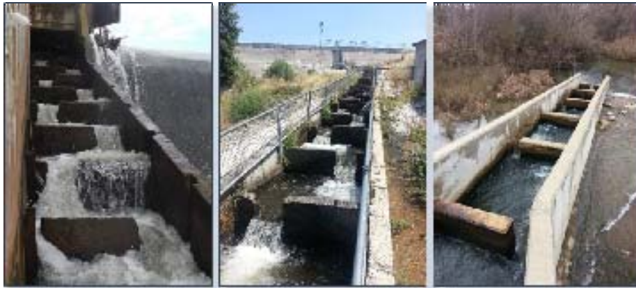
Figura 85. Escalas con diferentes tipos de resguardos laterales: demasiado reducidos (izquierda), inicialmente insuficientes, aunque solucionado mediante la posterior colocación de vallas (centro) y suficientemente grandes (derecha).
