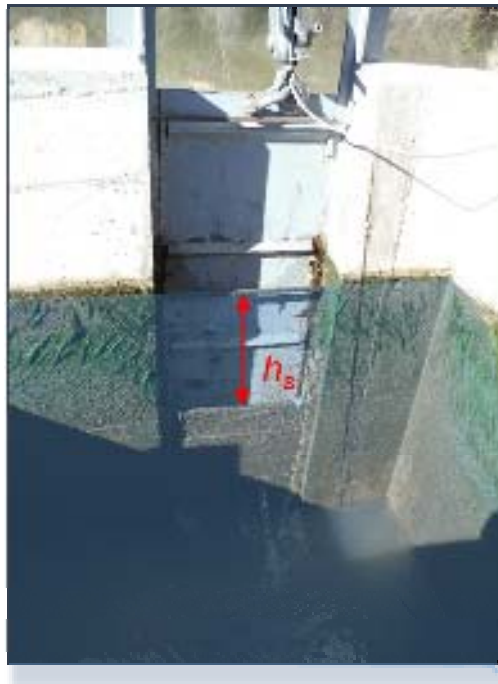
Figura 42. Profundidad en la salida vista desde el interior de la escala.
