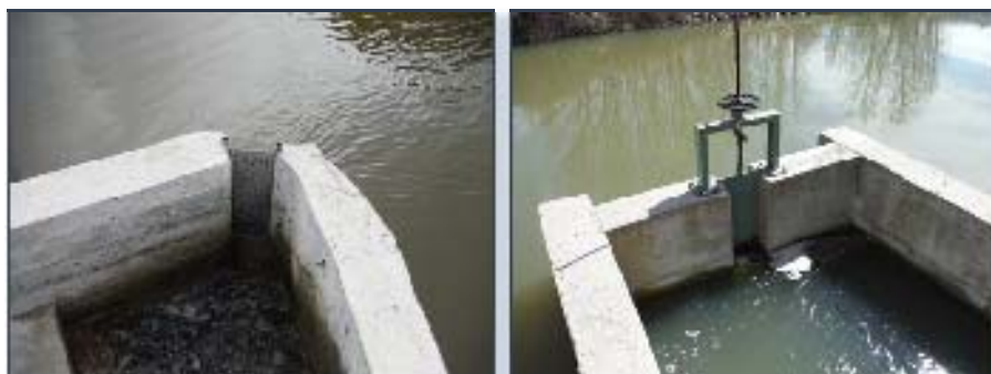
Figura 86. Diferentes compuertas para regular la entrada de agua en una escala.
