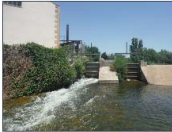
Figura 56. Compuertas para el vaciado del azud que se encuentran en la margen contraria a la escala, junto a la central hidroeléctrica.
