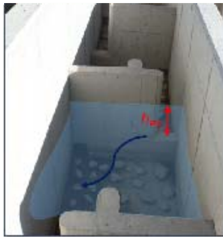
Figura 31. Ejemplo de la profundidad de paso sobre un vertedero (en rojo, y en azul se representa la dirección del flujo).
