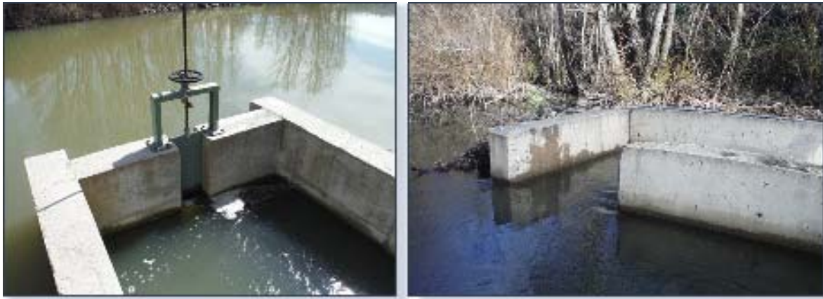
Figura 45. Salidas de peces con diferentes anchuras: 20 cm (izquierda) y 50 cm (derecha).
