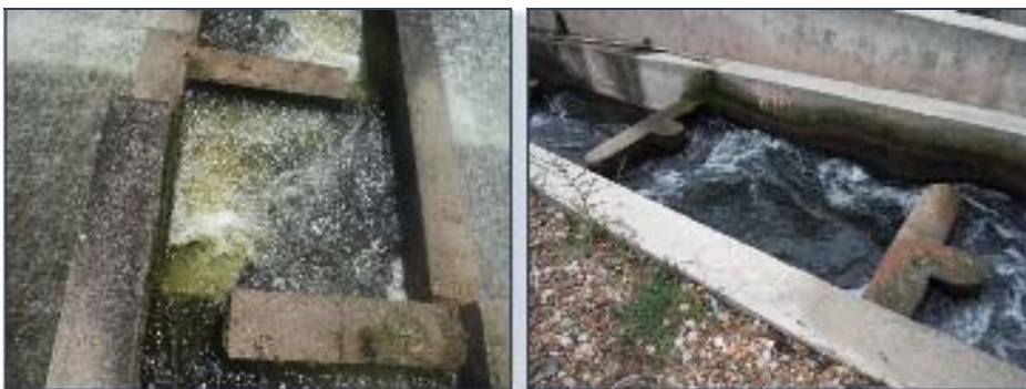
Figura 80. Estanques que presentan aristas vivas (izquierda) y redondeadas (derecha).
