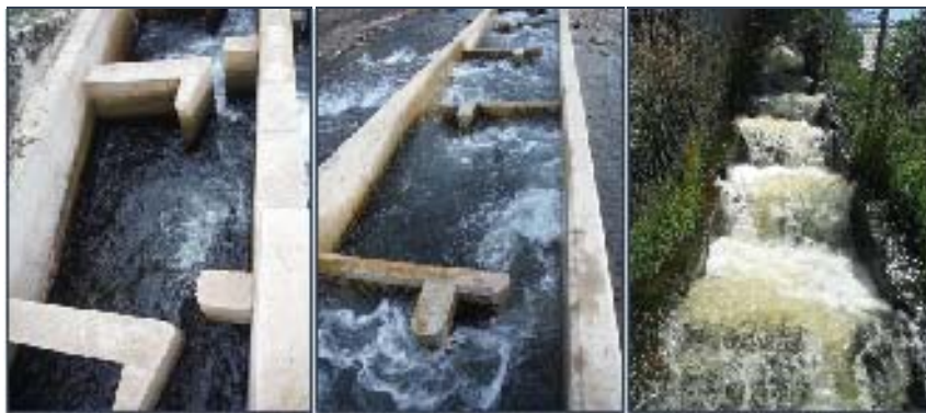
Figura 26. Estanques en los que la potencia disipada por unidad de volumen presenta un valor bajo ( < 50 \text{ W/m}^3 ) (izquierda), habitual ( 150 - 175 \text{ W/m}^3 ) (centro) y excesivo ( > 350 \text{ W/m}^3 ) (derecha).
