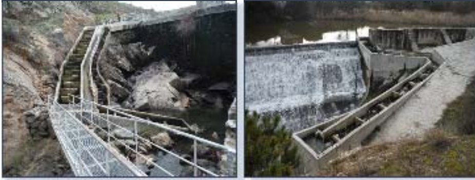
Figura 79. Pasarela (izquierda) y rampa en hormigón (derecha) que facilitan el acceso a dos pasos piscícolas.
