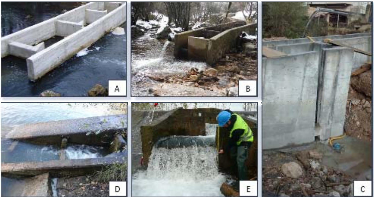
Figura 22. Diferentes tipologías de entradas para peces: hendidura vertical (A), vertedero libre + orificio (B), vertedero sumergido + orificio (C), vertedero sumergido (D) y vertedero libre (E).
